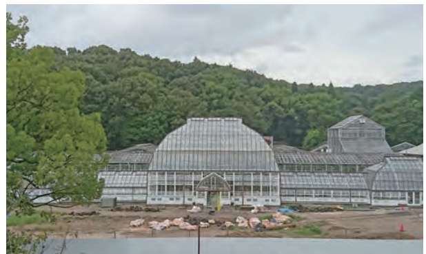
図4 国指定重要文化財温室 2020年9月撮影 保存修理工事を終えた温室。
