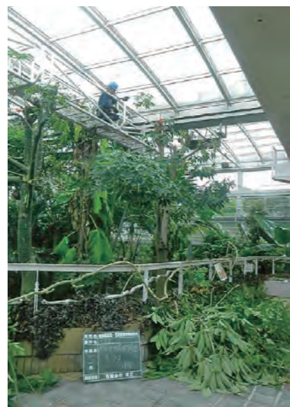
図19 メンテナンスラダーを使用した高木の剪定
