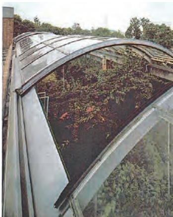
図7 可動式の天窗 日経アーキテクチャ1981年10月26日号p64より。
