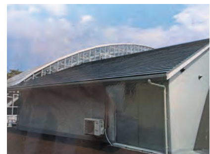
図13 外装完成（昼夜逆転室）
