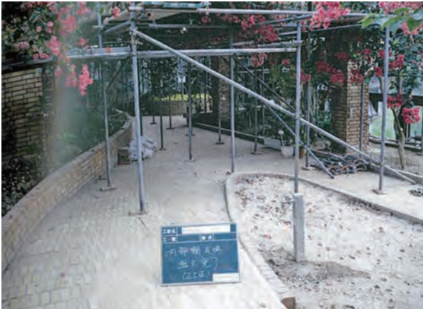
図26 足場の様子(廻廊温室)
