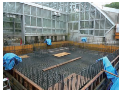
図10 基礎工事（昼夜逆転室）
