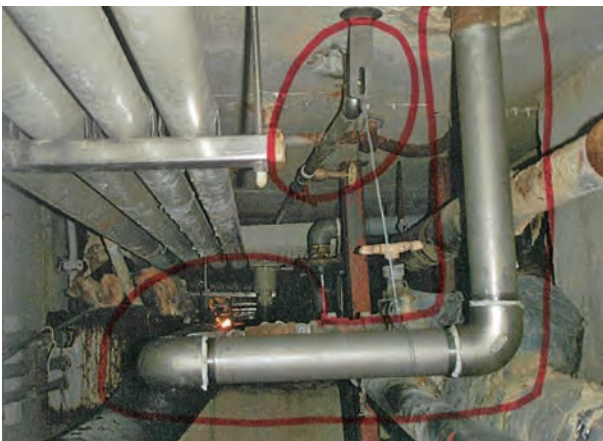
図28 ピット内配管の更新 赤い線で囲んだ部分。
