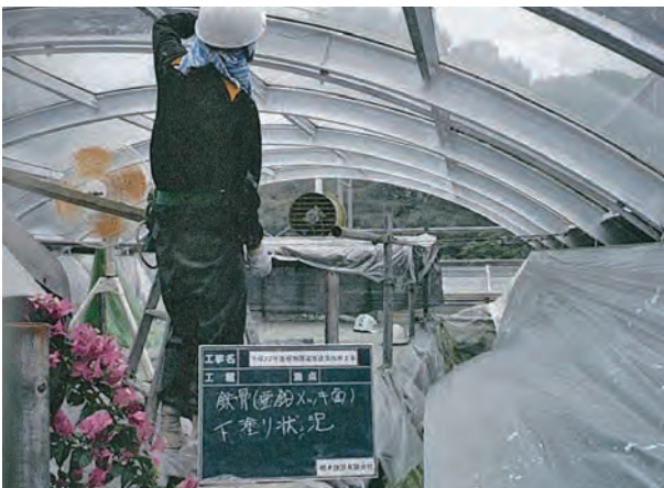
図27 天窓の補修塗装(廻廊温室)
