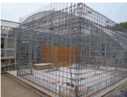
図11 鉄筋工事（昼夜逆転室）
