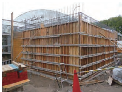
図12 型枠工事（昼夜逆転室）
