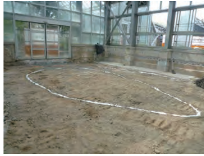
図19 土・地業工事（高山植物室）
