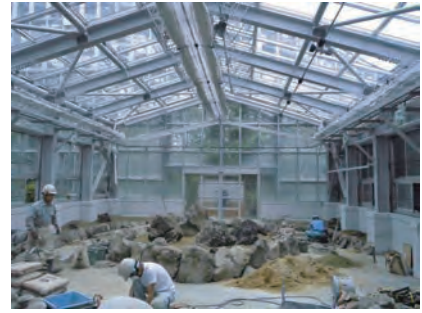
図20 石工事（高山植物室）
